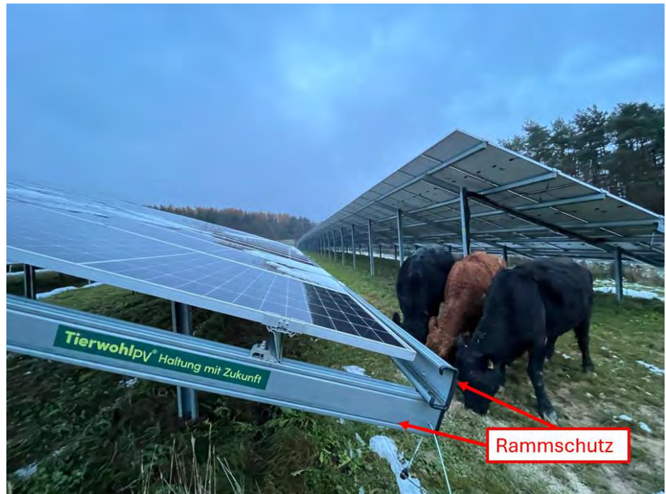
Foto 1: Modulaufbau Rammschutz Tierwohl PV
