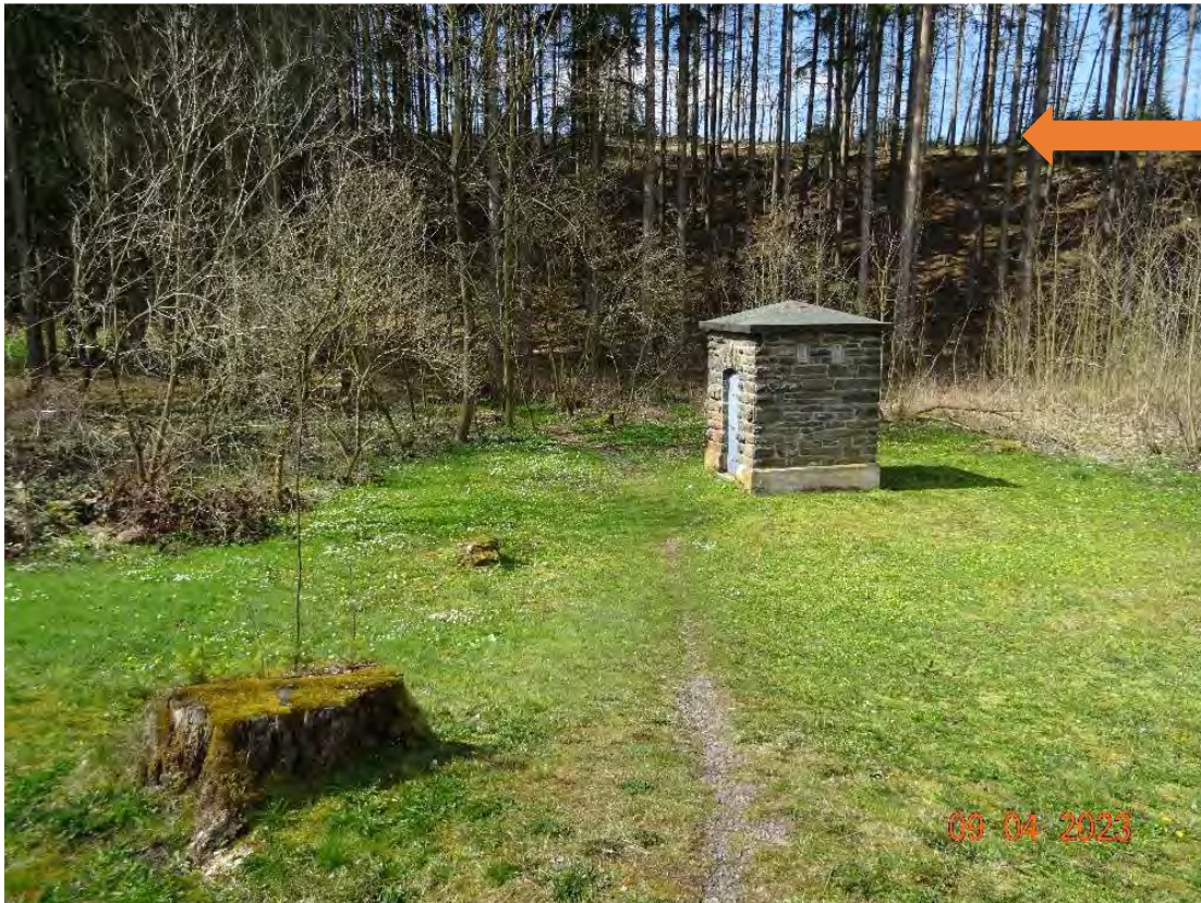
Bild 8: Einstiegsschacht (Schacht B) des Rohwasserüberleitungsstollens in 100m Entfernung von der südlichen Plangebietsgrenze (oranger Pfeil)
