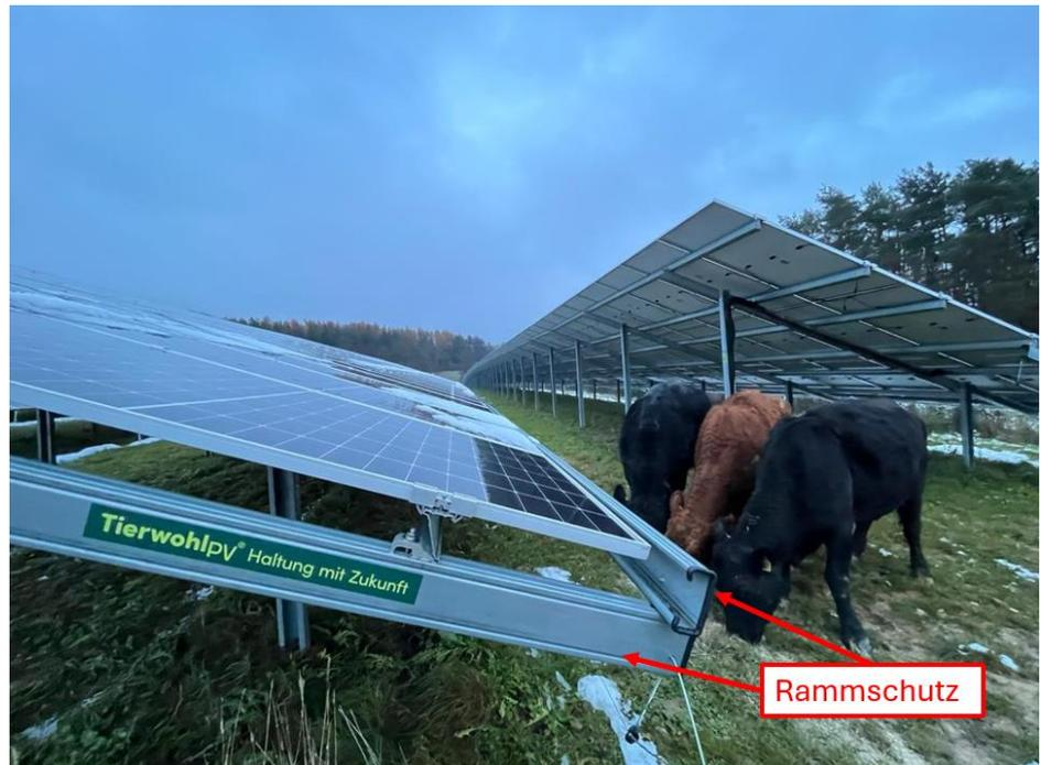
**Foto 1: Modulaufbau Rammschutz Tierwohl PV**
