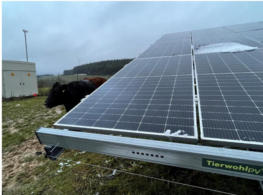
• **Foto 1: Stromlitzenführen am Rammschutz**
