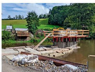
Brückenbau – Stand August 2021.
