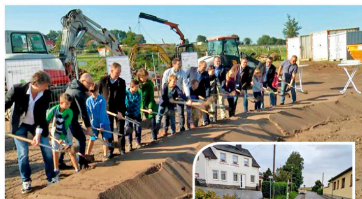
Erster Spatenstich am 3.9.2021.
