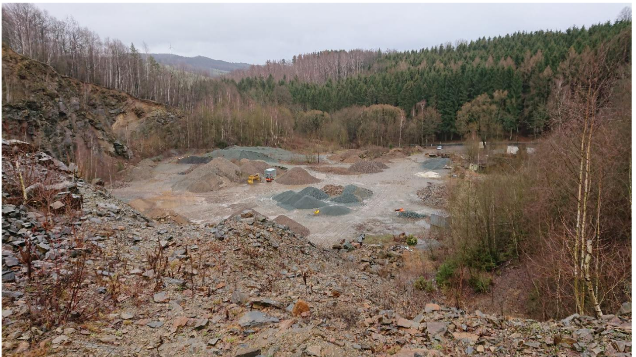
Bild 6: Blick von der oberen Nordwestecke über das Gelände
