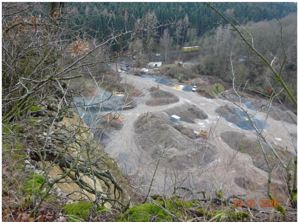
Bild 8: Blick in südwestliche Richtung zur S 235 (am oberen Bildrand)
