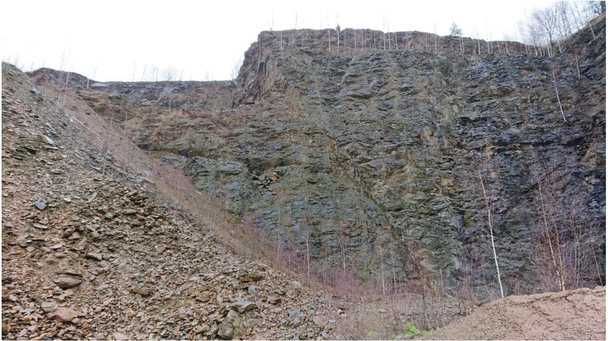
Bild 5: Teilansicht nördliche Felswand mit Haufwerk (links)
