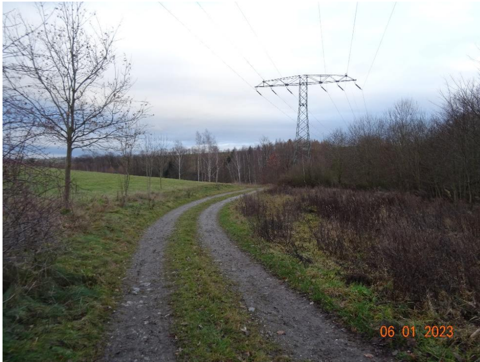
Bild 1: vorh. Zufahrt zum Plangebiet aus Richtung Dittmannsdorf / B180, im Hintergrund Mast Nr. 37 der 110-kV-Freileitung
