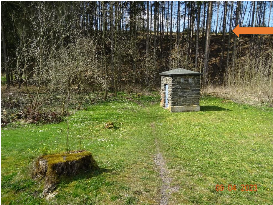
Bild 8: Einstiegsschacht (Schacht B) des Rohwasserüberleitungstollens in 100m Entfernung von der südlichen Plangebietsgrenze (oranger Pfeil)
